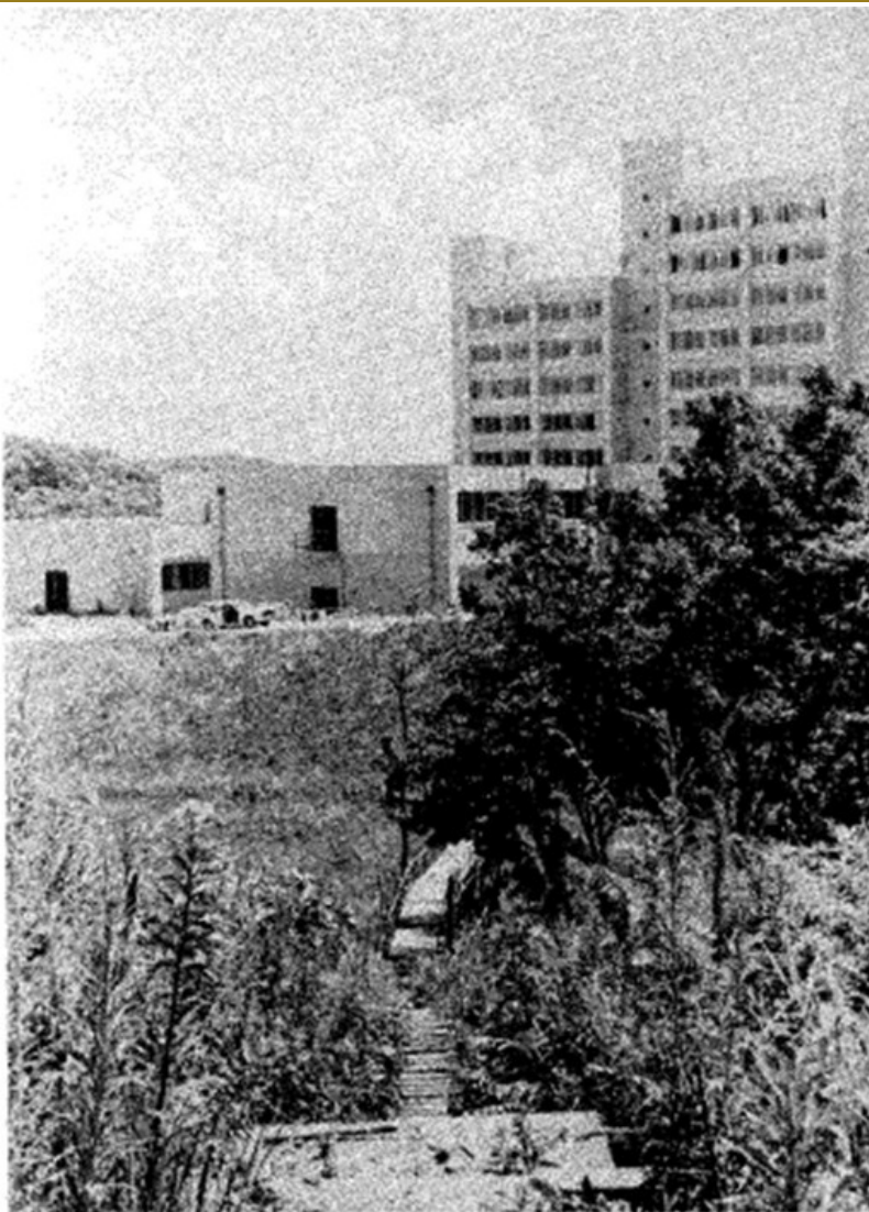
仮舗装前の「すずかけ通り」
