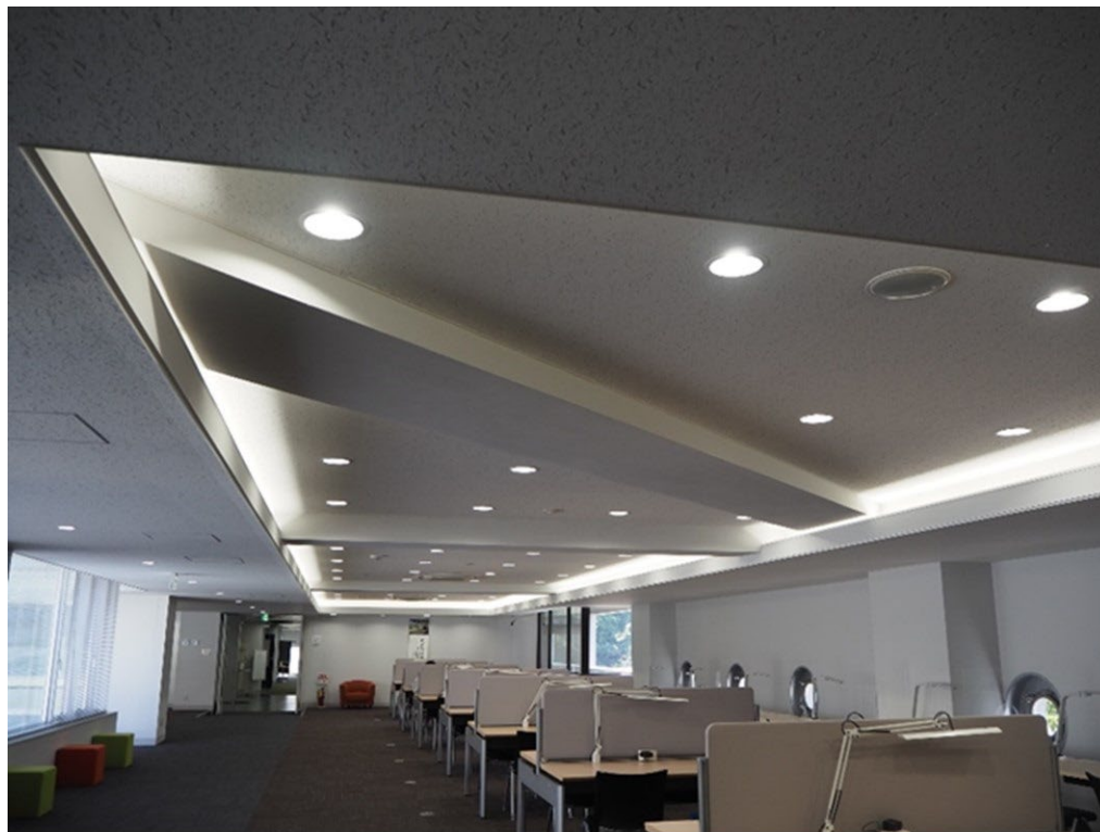
3階閲覧席の天井を斜めに走る梁 図書館サポーター撮影
